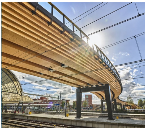
De passerelle, onderaanzicht
